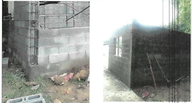
foto 2: debido al estado de columnas y fundiciones se inicio su sustitución.
